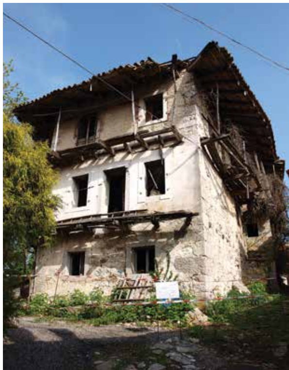
Kravarščakova hiša tik pred rušenjem.
